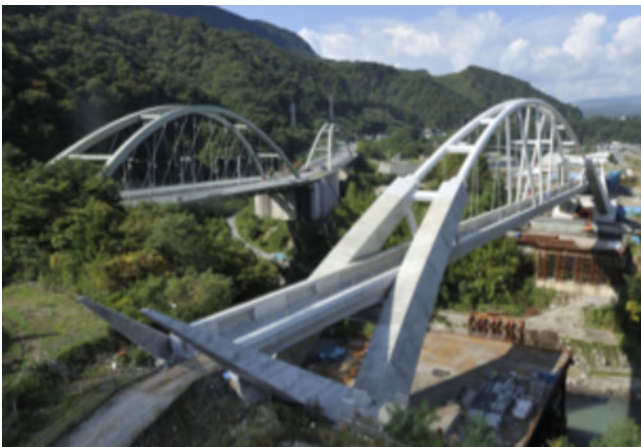
吾妻線 第三吾妻川橋りょう
