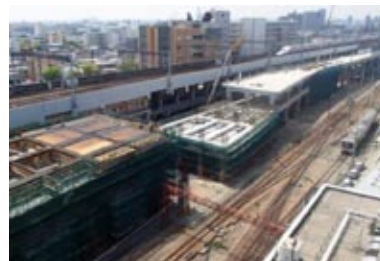
信越線新潟駅付近高架化
