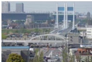
南武線稲城長沼駅付近高架化
