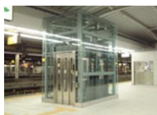
新宿駅中央線(快速)ホーム
