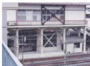
鉄骨ブレースによる補強
