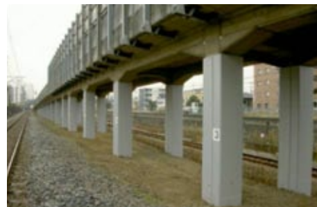
鋼板巻きによる高架橋柱の耐震補強
