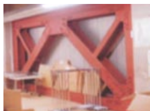
鉄骨ブレースによる補強
