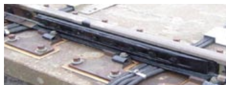
改良後の接着絶縁継目
