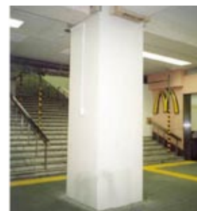
鋼板巻きによる柱の補強
