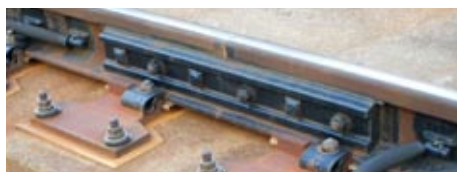
改良前の接着絶縁継目
