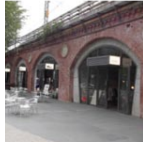
レンガ積みで建設されたアーチ高架橋
