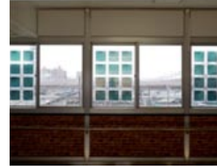
乗換ご線橋に設置した有機薄膜太陽電池（福島駅）
