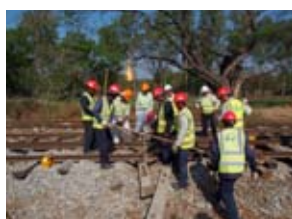
ミャンマーでの保線作業風景 (PCマクラギ交換)
