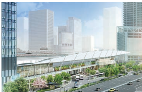
東京駅 グランルーフ (ダイナミックな膜屋根で賑わいの空間を生み出す グランルーフ)
