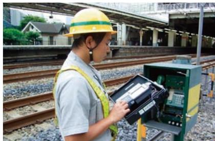
「保守作業用ハンディ端末」による線路閉鎖手続き
