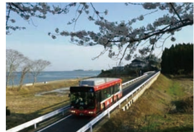
完成したBRT専用道路と走行するバス
