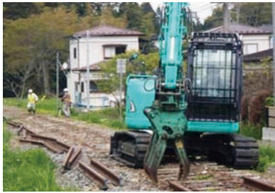
被災地の軌きょう(レール、バラスト、マクラギ)撤去
