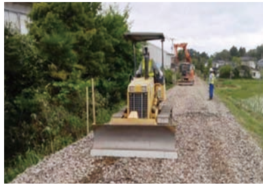
BRT専用道路の路床に発生バラスト改良体を転用
