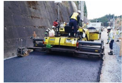
BRT専用道路へのアスファルト舗装
