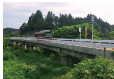
幅員を広げた鉄道橋りょう上を走行するバス
