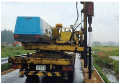
被災レールの土留用杭としての転用 (レールの打込み状況)
