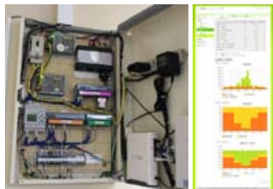
エネルギー管理効率をあげる人工知能盤を設置し、視える化を実現
