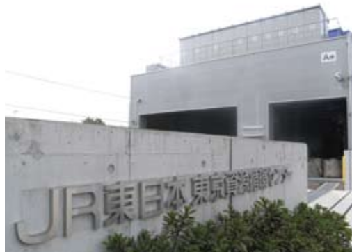
JR東日本東京資源循環センター
