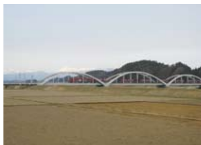
連続したコンクリートアーチ橋を採用し、青森の山々と田園の景観との調和を図った東北本線北上町～乙供間天間川橋りょう（土木学会デザイン賞2008優秀賞受賞）
