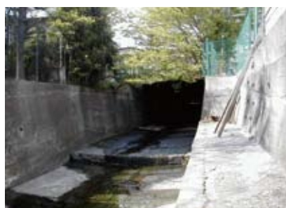
立会川への送水
