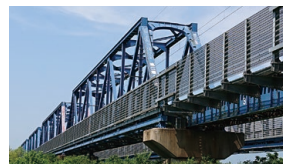
羽越本線 北余目～砂越間
