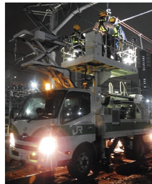
架線点検作業
