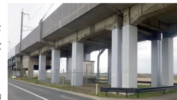
高架橋柱耐震補強
