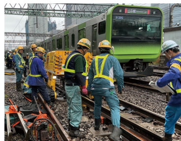
日中時間帯に おける作業・工事 (京浜東北線)
