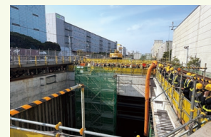
IR DAY(羽田空港アクセス線(仮称) プロジェクト現地見学会)
