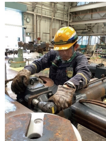
技能実習生による台車枠への ユニットブレーキ取り付け作業
