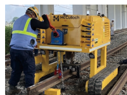
レール交換の機械化風景
