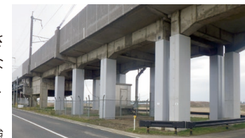
高架橋柱耐震補強
