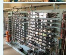
特に力を入れる修繕内容 (レール交換、 信号リレー取替)
