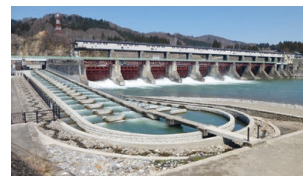
魚道の整備(宮中取水ダム)
