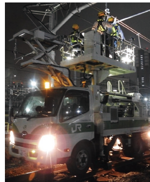
架線点検作業
