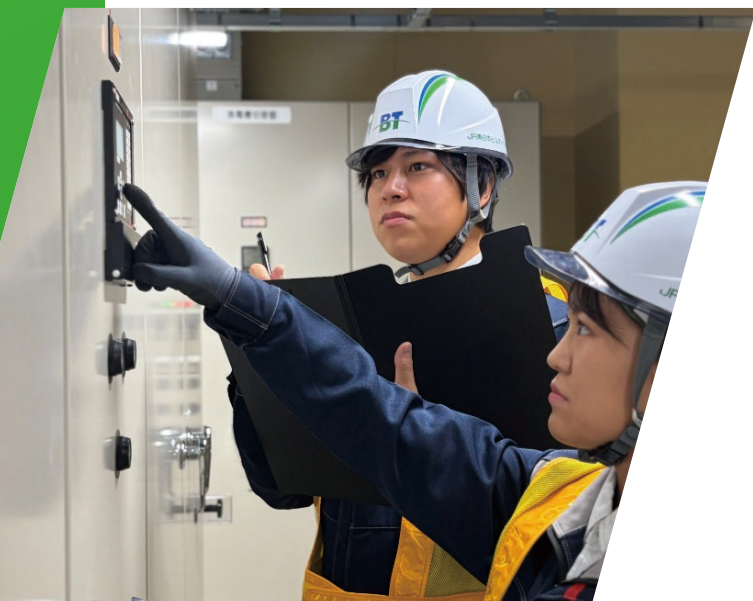
配電盤検査に携わる社員（JR東日本ビルテック㈱）
