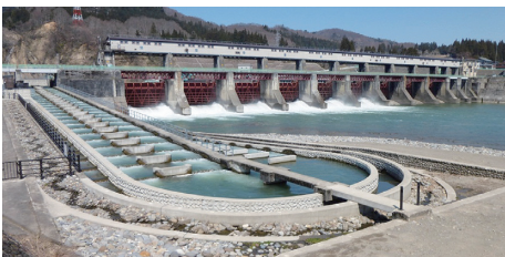
魚道の整備 (宮中取水ダム)
