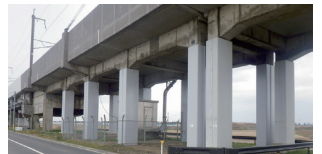
高架橋柱耐震補強
