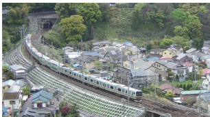
盛土のり面工(吹付砕工)
