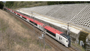
切取のり面工(吹付砕工)
