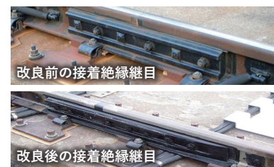
改良後の接着絶縁継目
