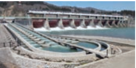
魚道の整備 (宮中取水ダム)
