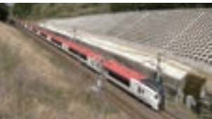
切取のり面工（吹付砕工）
