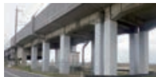
高架橋柱耐震補強
