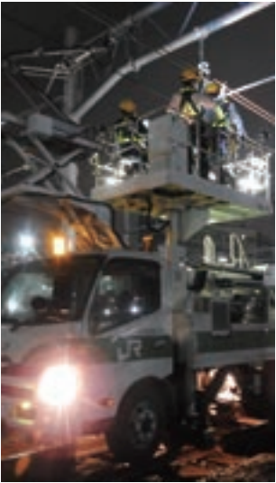
架線点検作業
