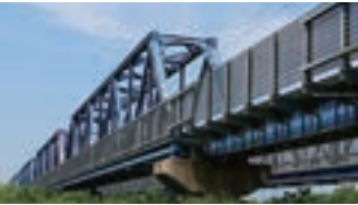
羽越本線 北余目～砂越間
