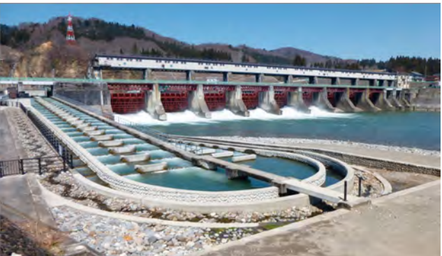
魚道の整備(宮中取水ダム)
