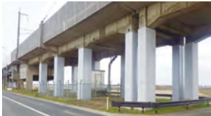
高架橋柱耐震補強
