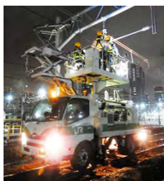
架線点検作業
