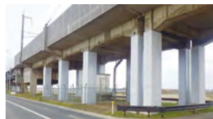
高架橋柱耐震補強
