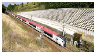
切取のり面工（吹付砕工）
