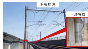
電柱耐震補強
