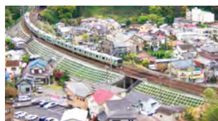
盛土のり面工（吹付砕工）
