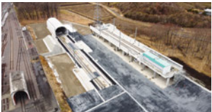
実物大の新幹線模擬設備
