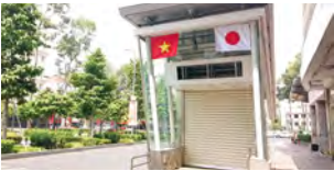
ホーチミン市都市鉄道1号線の開業準備
