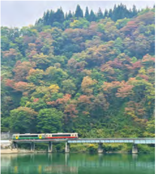
只見線全線運転再開(第八只見川橋りょう)
