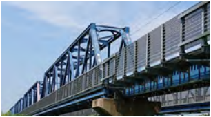
羽越本線 北余目～砂越間
