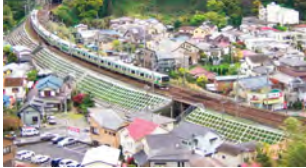
盛土のり面工（吹付砕工）
