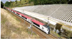
切取のり面工（吹付砕工）
