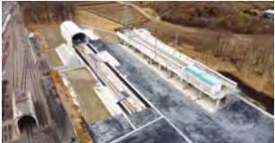
実物大の新幹線模擬設備
