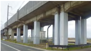
高架橋柱耐震補強
