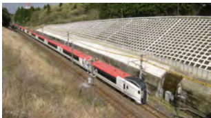
切取りの面工（吹付砕工）
