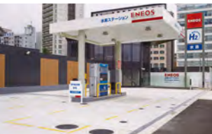
水素ステーション
