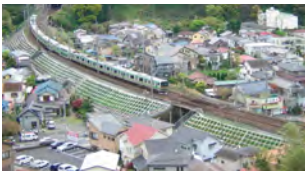
盛土のり面工（吹付砕工）
