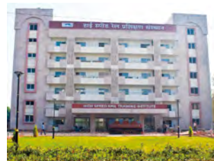
建設中のインド高速鉄道 研修センター宿泊棟
