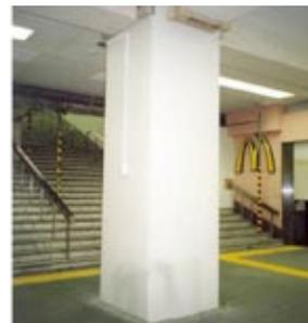
鋼板巻きによる柱の補強
