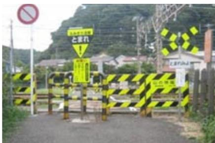
自動車通行禁止の踏切に「交通規制柵」を設置します。
