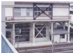
鉄骨ブレースによる補強
