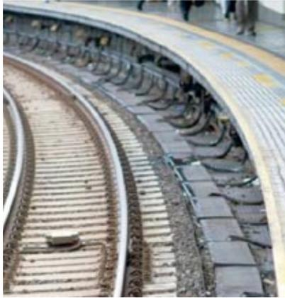
ホーム下に設置したマットで転落者を検知し、列車に停止を指示します。
