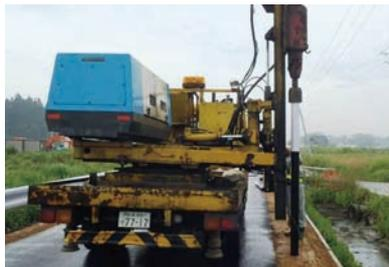
被災レールの土留用杭としての転用(レールの打込み状況)
