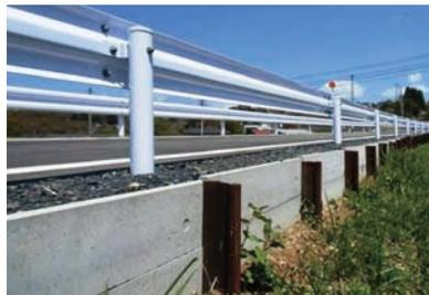
道路端部の土留用RC板と被災レール杭
