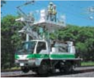
線路上も走行可能な作業車による、安全な高所作業の実施
