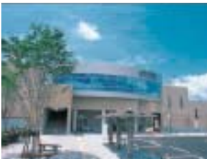
コミュニティセンターを併設した左沢線「寒河江駅」
