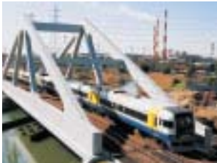
内房線姉ヶ崎川橋りょうでは、構造や塗装色を工夫することで周辺への圧迫感を和らげています
