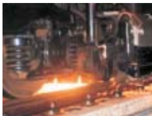
列車の走行により凹凸の生じたレールを滑らかにします
