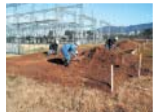
漂流ゴミからつくったマルチング材を施設内に敷設します
