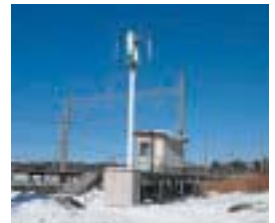
津軽線郷沢駅に設置された風力発電機は、風向きに左右されず風車が回るタイプです
