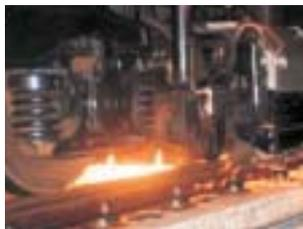
列車の走行により凹凸の生じたレールを滑らかにします
