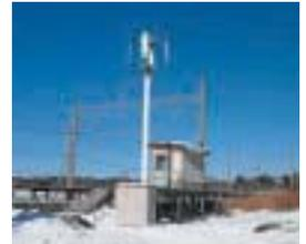
津軽線郷沢駅に設置された風力発電機は、風向きに左右されず風車が回るタイプです
