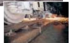
\*1 レール削正:列車走行により凹凸の生じたレールを滑らかにすること。
