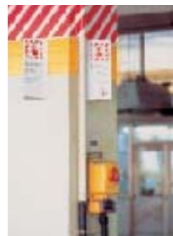
列車非常停止警報装置
