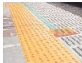
視覚障害者誘導用ブロック
