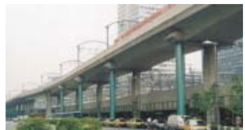
中央線東京駅付近高架橋
