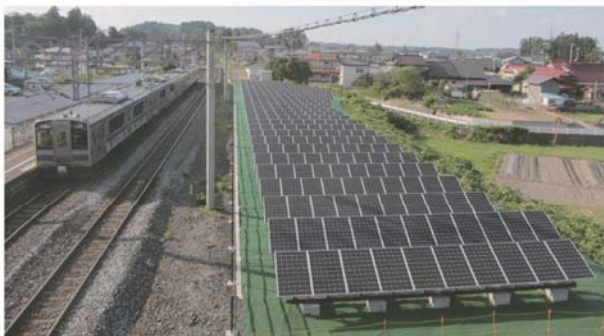
鉄道沿線の太陽光パネル
