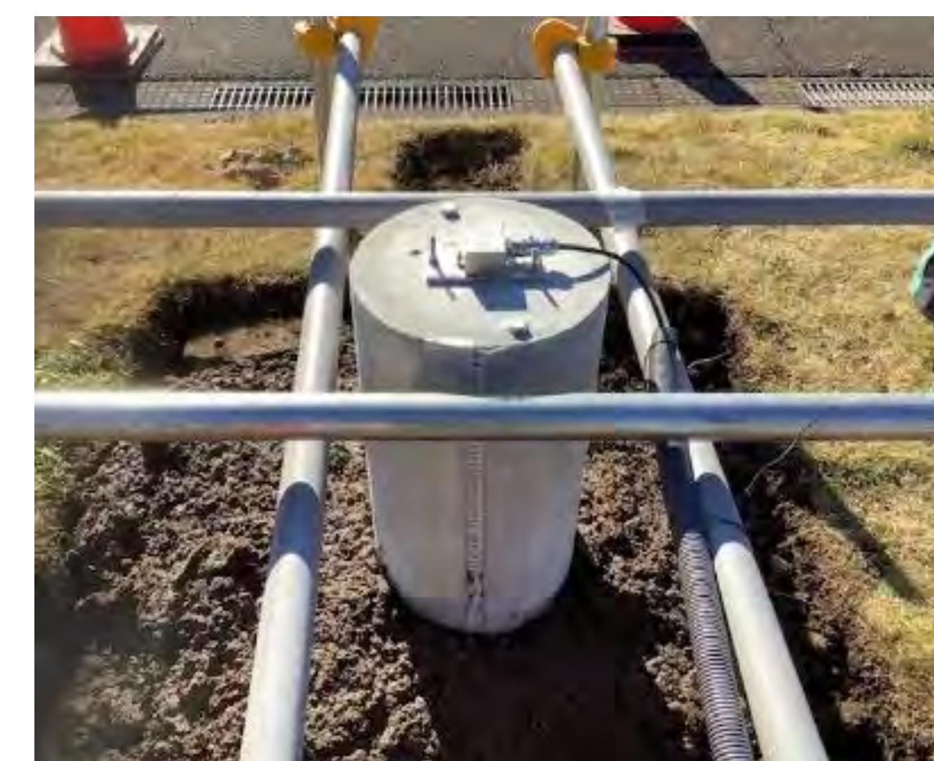
写真2 動作試験状況
