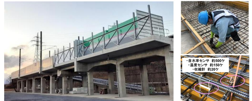
実物大模擬設備 埋設センサ等設置状況
