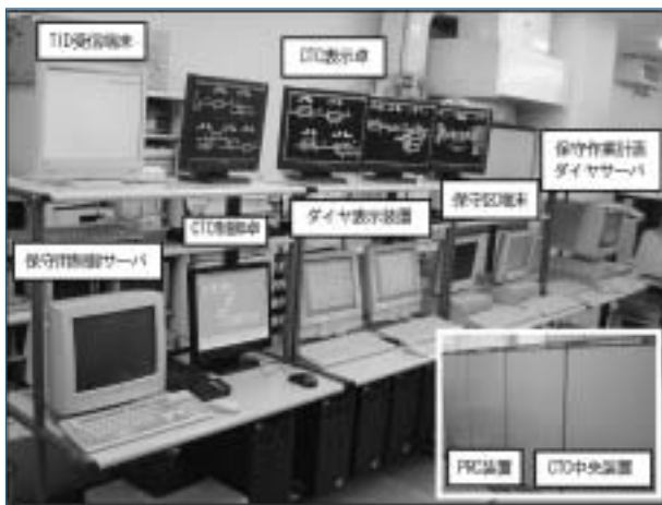
図12：現地検証試験仮設機器
