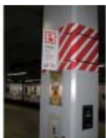
図6：列車非常停止警報装置
