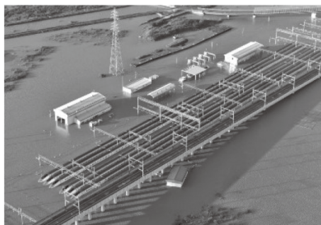
図1 2019年台風19号による長野新幹線車両センターの浸水状況(10月13日16時30分頃撮影)
