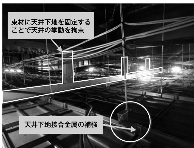
写真9 耐震クリップ・ハンガー工法
