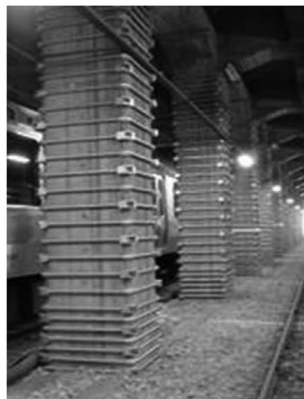
写真7 RB耐震補強工法
