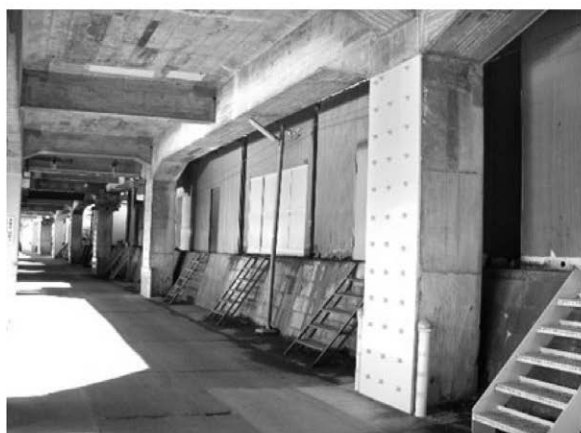
写真8 一面耐震補強工法
