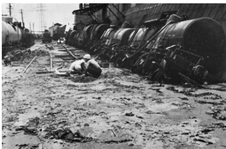
写真2 1964 新潟地震で発生した液状化による列車脱線 3)
