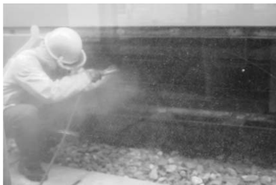
図1：床下機器の気吹き清掃作業
