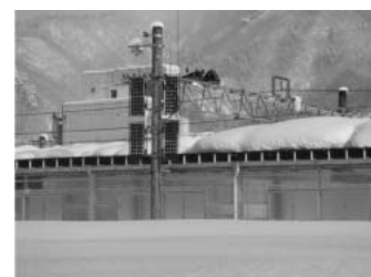
図12：積雪地域における独立電源としての試験（越後湯沢駅構内）
