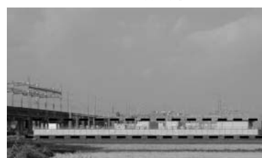
図11-2：新幹線変電所フェンス
