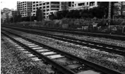
図5 あとてん充工法施工箇所(施工後)
