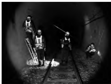
図12 現在のトンネル断面変位計測状況
