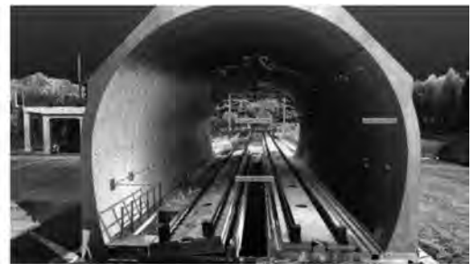
図16 点群データからの基準点自動抽出状況
