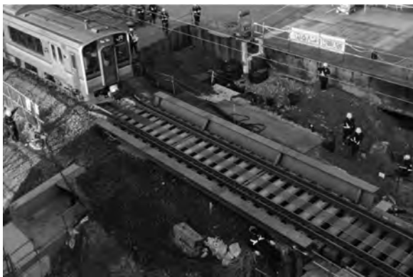
図15 斜ウェブ工事桁の架設状況
