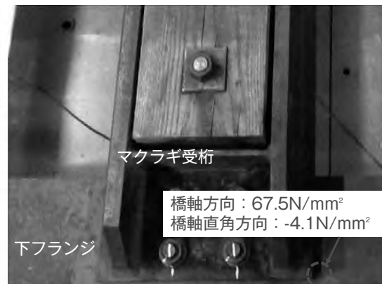
図10 主桁下フランジのマクラギ受桁との接合部
