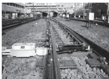
図1 次世代分岐器(2000型)
