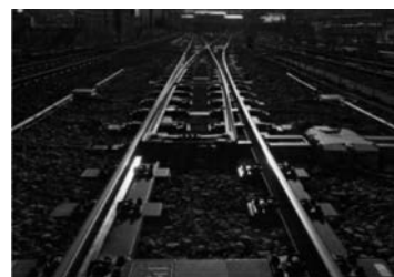
図6 分岐器敷設状況
