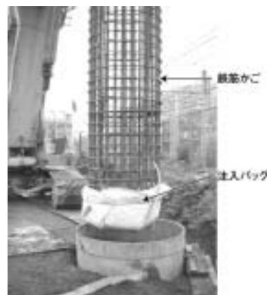
図5：先端プレロード場所打ち杭
