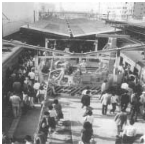
図1：TBH杭によるホーム上での施工状況
