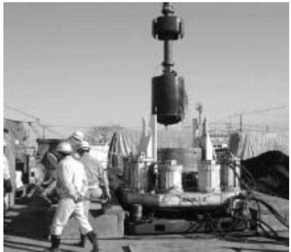
図11：軸部掘削状況
