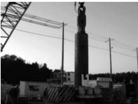
図10：セーフティガード管(口元管)建て込み状況
