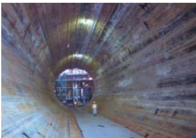
図12：HEP & JES工法で構築した地下空間
