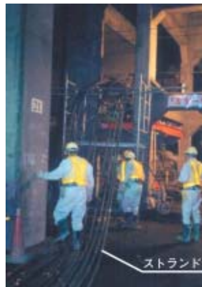
図8：ストランド建込み状況
