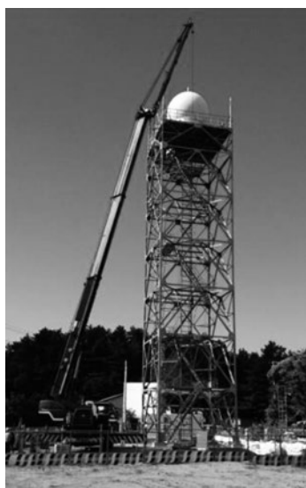
写真1 建設中の新ドップラーレーダ基地局
