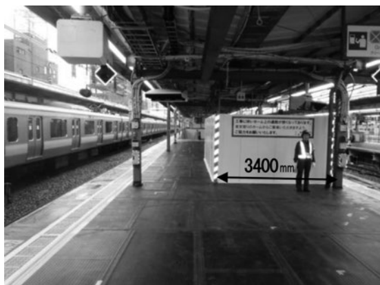
図16 超低空頭杭仮囲 (3.4m×6.5m)
