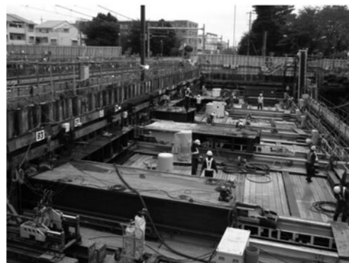
図5 ニツ家こ道橋 地盤切削JES工法施工状況
